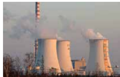
Elektrownia Jaworzno, Polska
