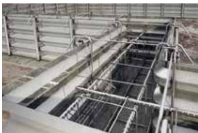
Fundamenty i Ławy
