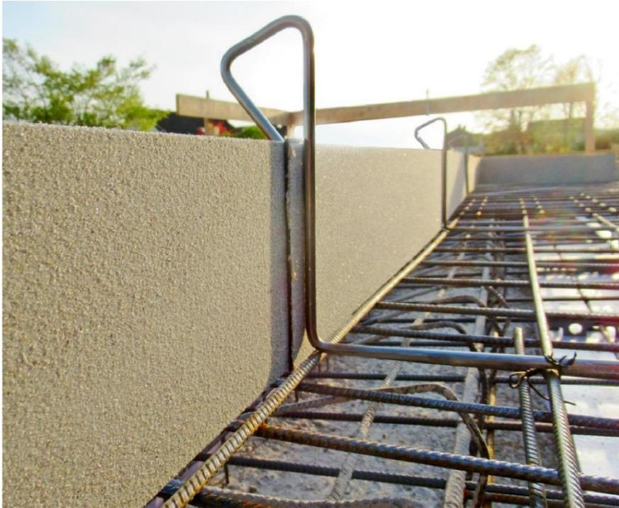
contecSEAL 167JGS – Fugenblech für die dauerhafte, innenliegende Abdichtung von Arbeitsfugen in WU-Betonkonstruktionen von Biogas- und JGS- Anlagen. Behälter für Jauche, Gülle und Gärsubstrate landwirtschaftlicher Herkunft können sicher abgedichtet werden. Auch geeignet für Betonflächen auf denen wassergefährdende Stoffe und Gärsubstrate landwirtschaftlicher Herkunft gelagert und abgefüllt werden.
