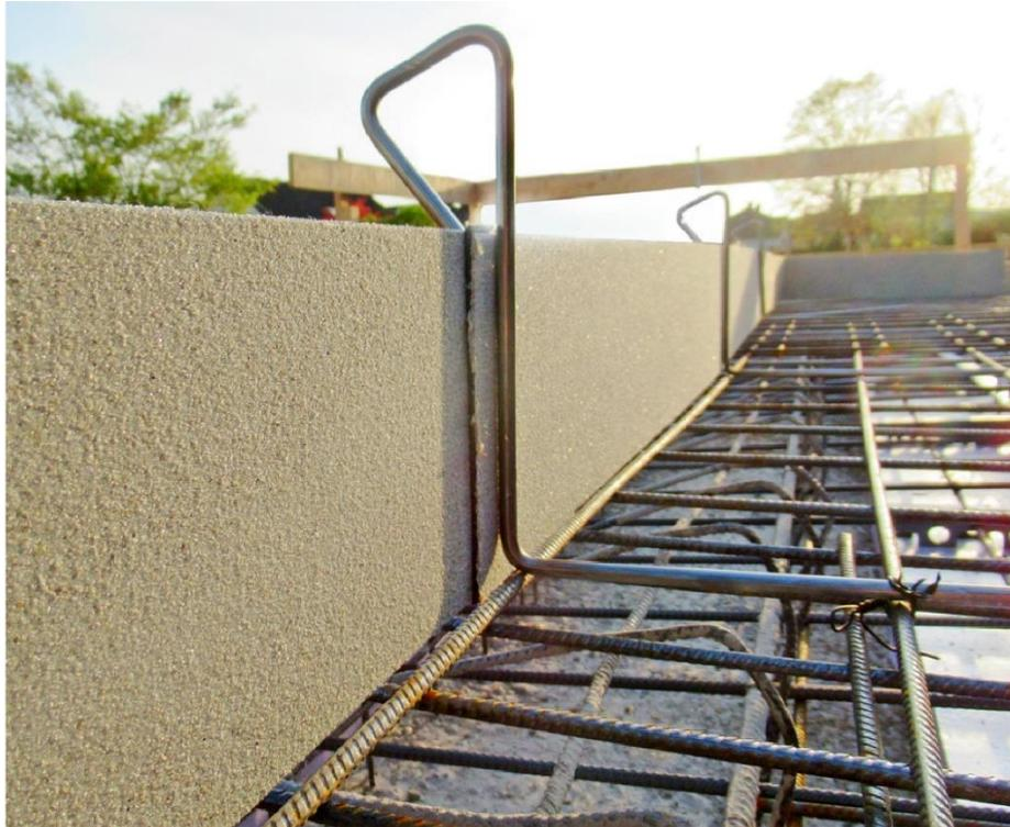
contecSEAL 150 – Fugenblech mit beidseitiger, elastischer Beschichtung und Spezialgranulat für die dauerhafte, innenliegende Abdichtung von Arbeits- und Sollrissfugen in WU-Betonkonstruktionen im Hoch-, Tief- und Ingenieurbau gegen drückendes und nicht drückendes Wasser
