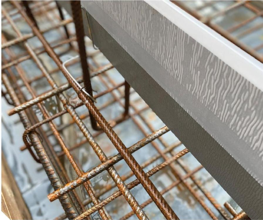
conSTIC 150 - Fugenblech mit beidseitiger, elastischer Spezialbeschichtung
