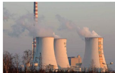
Elektrownia Jaworzno, Polska
