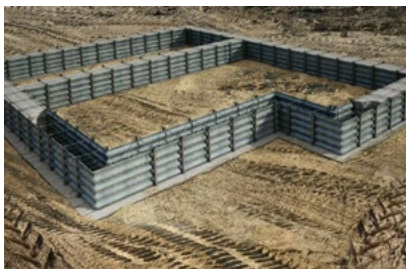
Fundamenty i Ławy
