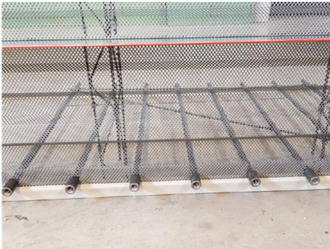
Die Lösung: RECOSTAL® Abschalelemente mit RECOSTAL® Coupler bieten eine optimale Montage auf Frischbetonverbundabdichtungen mit Durchflusssicherung für den sicheren Hinterlaufschutz.
