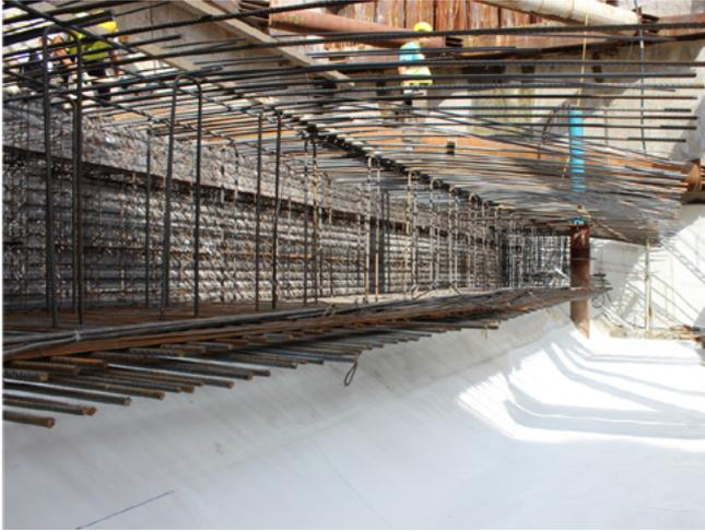
Herkömmliche Ausbildung der Anschlussbewehrung. Frischbetonverbundabdichtung muss weit in den nächsten Betonierabschnitt vorverlegt werden.
