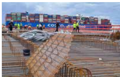
LNG-Terminal an Land in Stade, Deutschland
