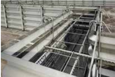
Fundamente, Randschalungen und Köcher
