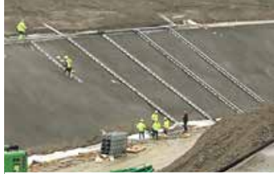
Kraftwerk Töging-Jettenbach, Deutschland
