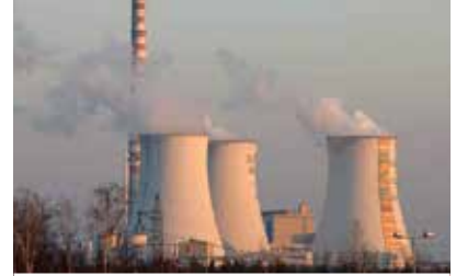
Kraftwerk in Jaworzno, Polen
